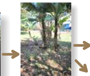
Mais adiante, a estação de tratamento do esgoto, ou fossa séptica, que separa os sólidos da água por meio de um filtro de pedras e raízes
